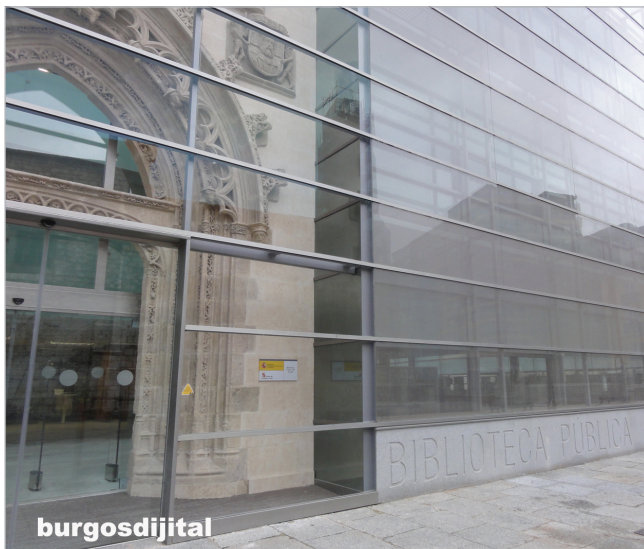
Figura 4. Detalle de la fachada de la BPE de Burgos Fuente: http://burgos-dijital.blogspot.com.es
