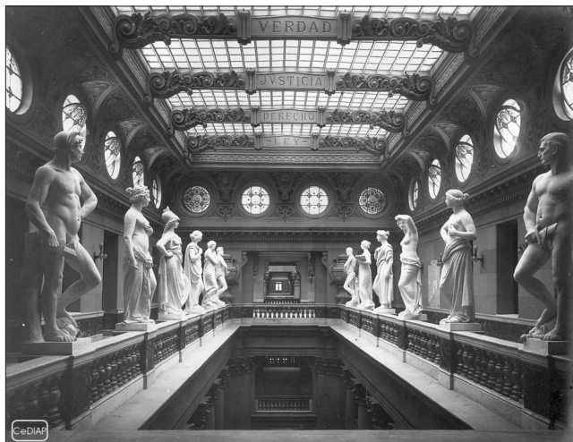
Palacio de Justicia en Ciudad de Bs. As. Fotografía n° 00246. Galería estatuas. MOP
