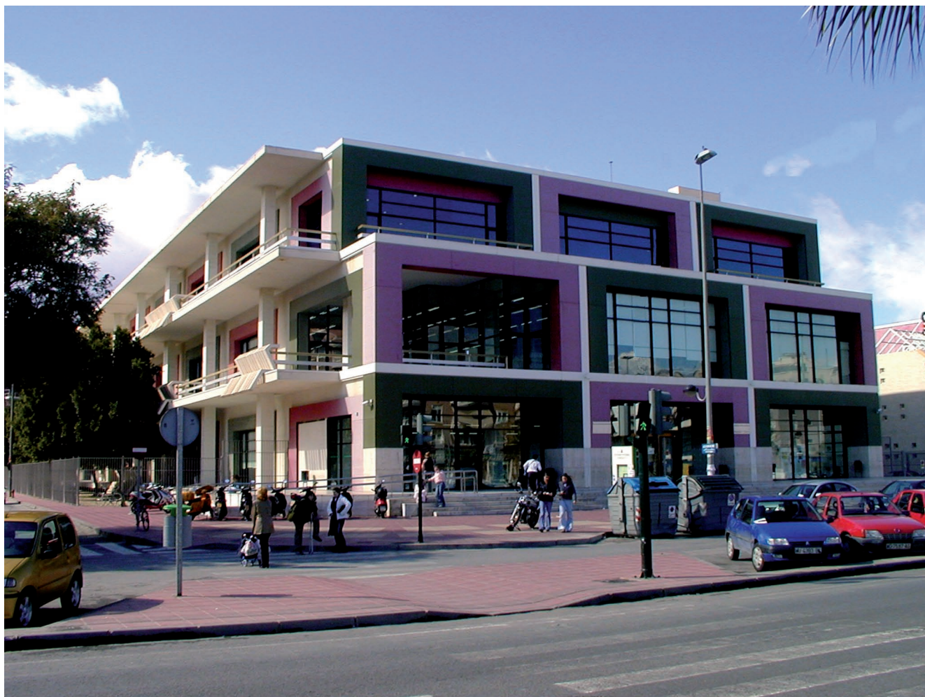
Biblioteca Regional de Murcia (BRMU): exterior
